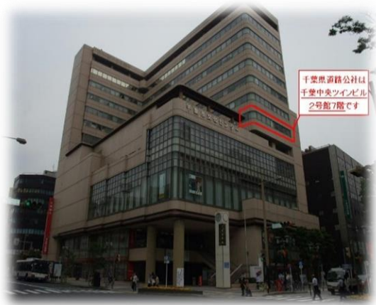
本社が入る千葉中央ツインビル
